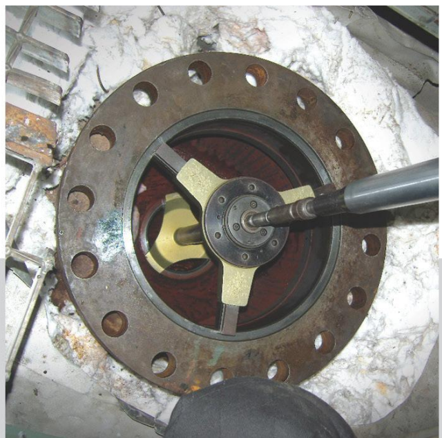
* Standard seating angle | 현장 밸브에 따라 다양한 톨 제작이 가능
